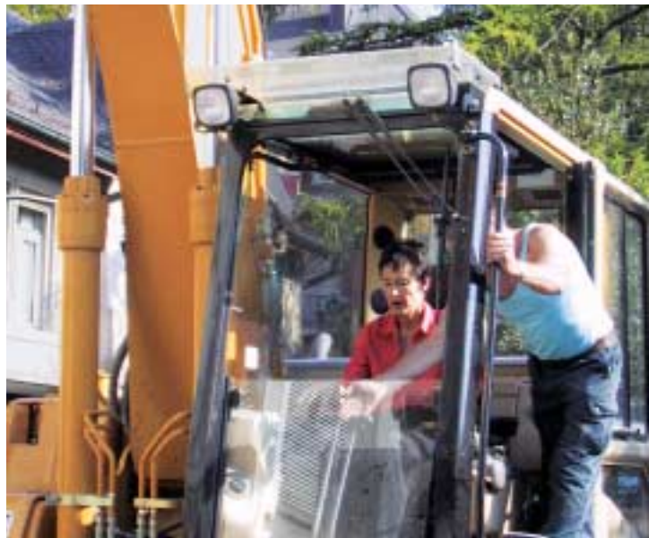
Am 22. September 2003 erfolgte der Spatenstich im Rigiblick. Umbau und Renovation sind seither in vollem Gange. Die Eröffnung findet im Dezember 2004 statt.
